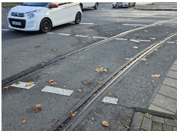
Abb. 3 + 4: Unebenheiten am Bahnübergang Sülzgürtel / Lux
